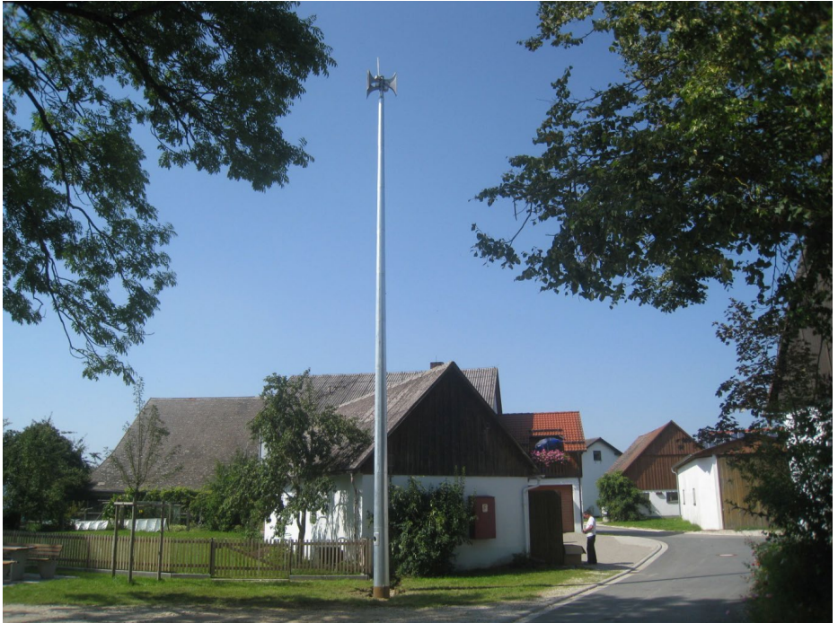
Elektronische Sirene vom Typ Hörmann ECI 600 in Ballertshofen
