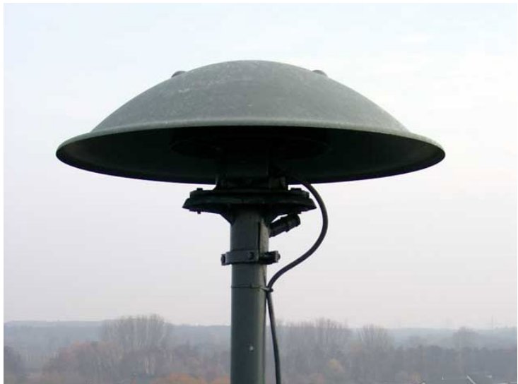
Motorsirene vom Typ E57 in Deinschwang
