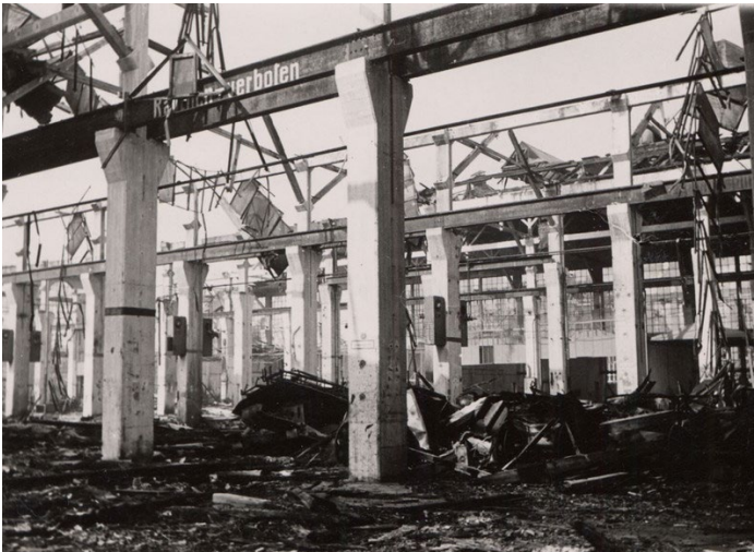
Durch Luftangriff zerstörte Fabrikhalle der Feuerwehrgerätefabrik Carl Metz in Karlsruhe
