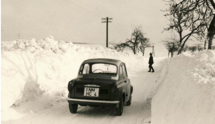
Freigeräumte Straße bei Deinschwang
